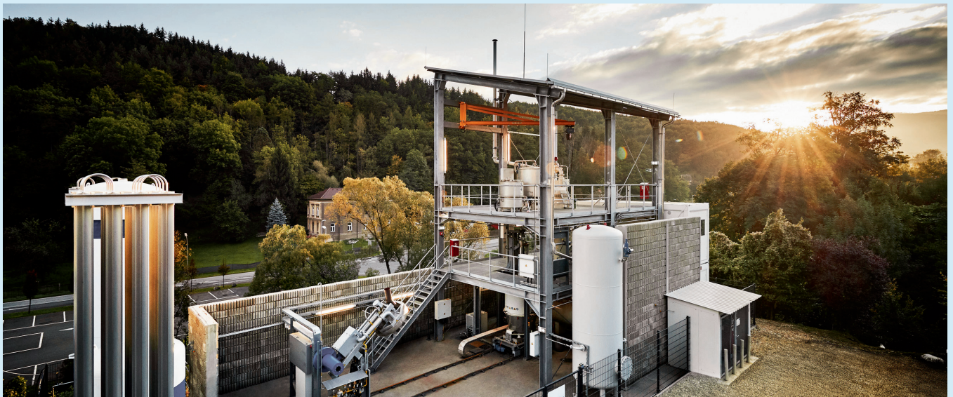
Abb. 25: Überblick über die Demonstrationsanlage zur Wasserstoffplasma-Schmelzreduktion. Quelle: voestalpine Stahl Donawitz, K1-MET
